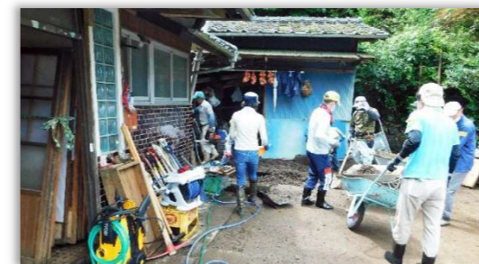
ボランティアによる民家での土砂掻き出し作業の様子。
