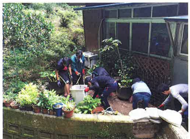
江迎地区被災された住宅の片付け作業
