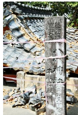
崩れた手水舎
