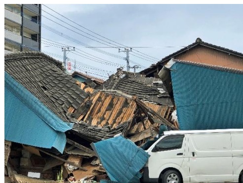
倒壊した家屋
