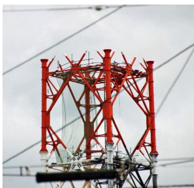
解体中の地域のシンボル
